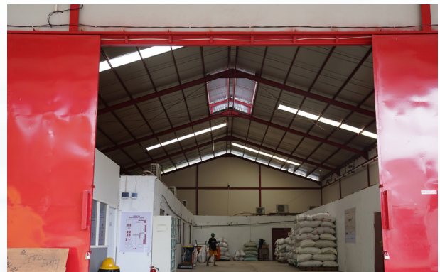
Relokasi Gudang Ambon untuk Memperkuat Efisiensi Operasional
